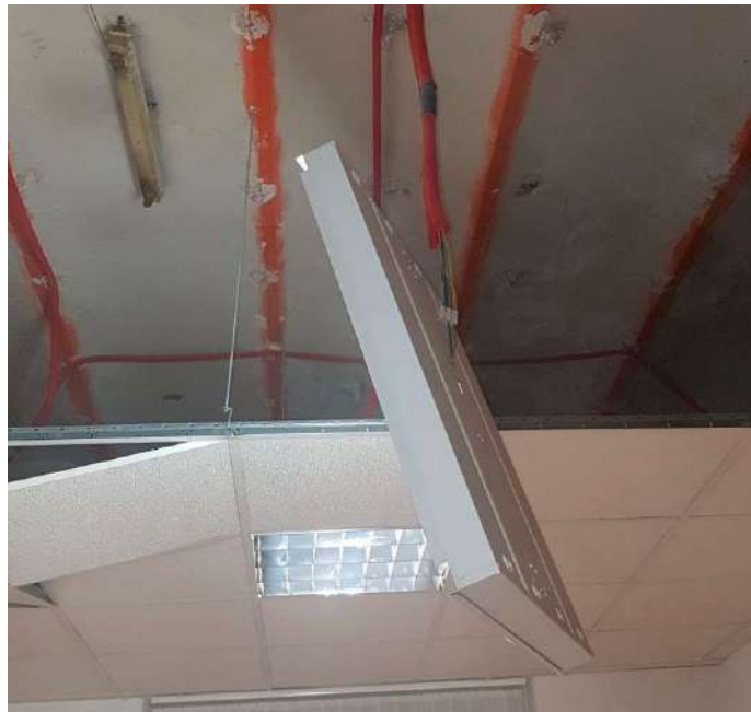
El techo falso de una de las salas de un edificio anexo del cuartel de Batalla del Salado se vino abajo.
