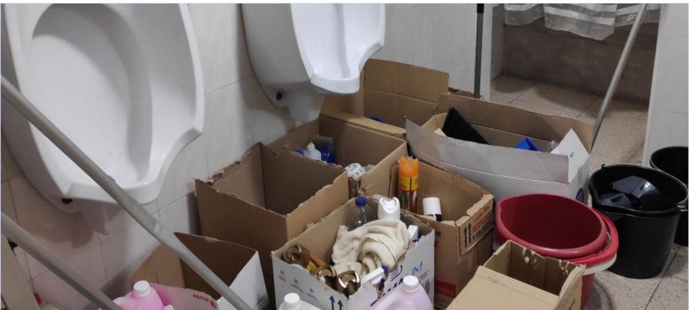
Estado de los servicios de las instalaciones del Seprose de Barcelona.
